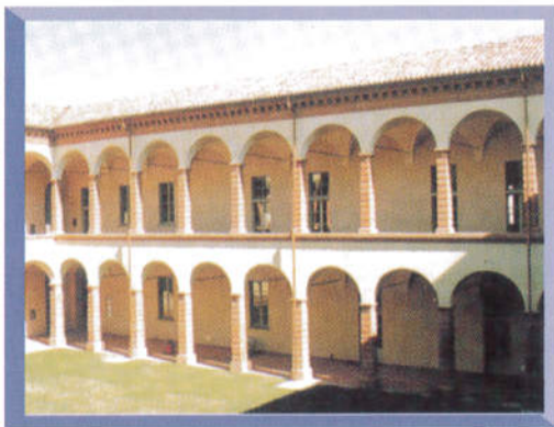
Ex-Caserma della Neve (Loggiato interno)
