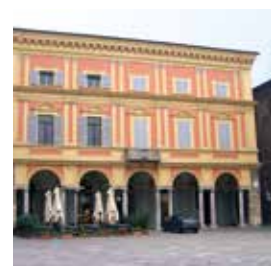
■ Palazzo dei Mercanti (1676- 1697) • Façade
