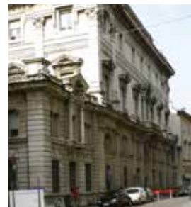
■ Palazzo della Provincia (from 1912) • Façade
